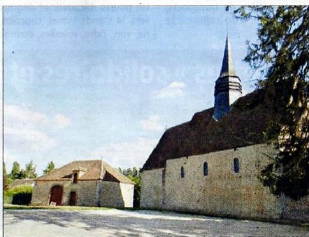
L'exemple d'un bâti rural préservé et valorisé : le pressoir communal de Rozoy, à l'ombre de son église classée...
